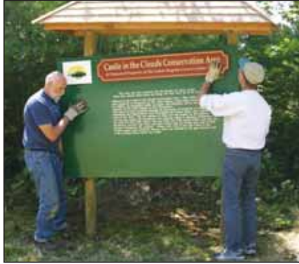
Installing the Kiosk
